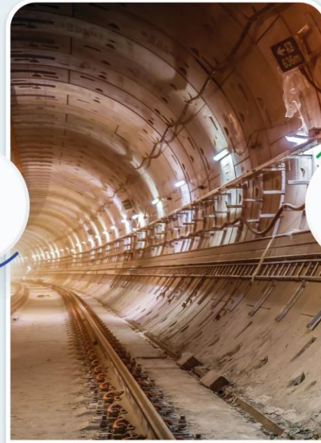
ผู้ที่ทำงานใน ที่อับอากาศ
