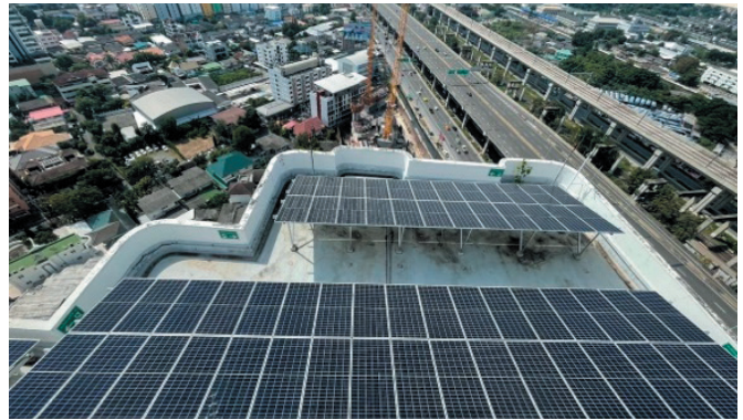
รูปภาพการติดตั้งแผงโซลาร์บนดาดฟ้าแต่ละอาคาร
