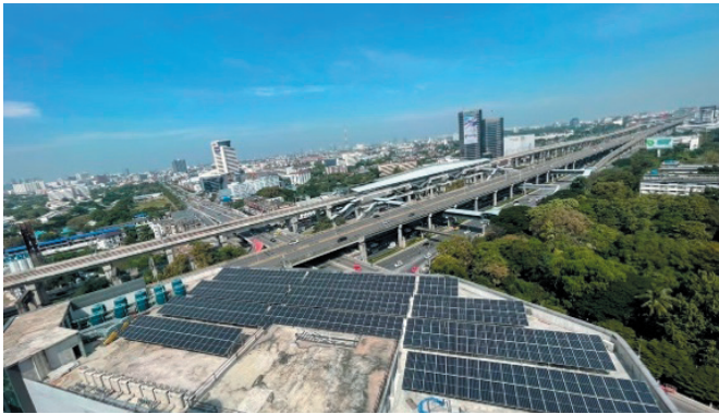
รูปภาพการติดตั้งแผงโซลาร์บนดาดฟ้าแต่ละอาคาร
